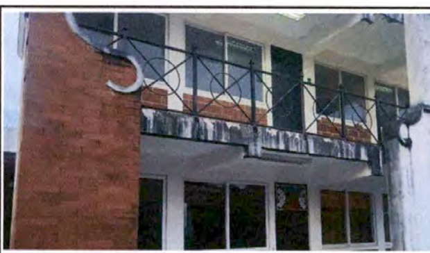
Foto 6: Modulo nuevo Aulas
