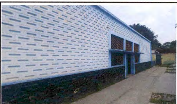
Foto 4: Fachada escuela modulo viejo aulas
