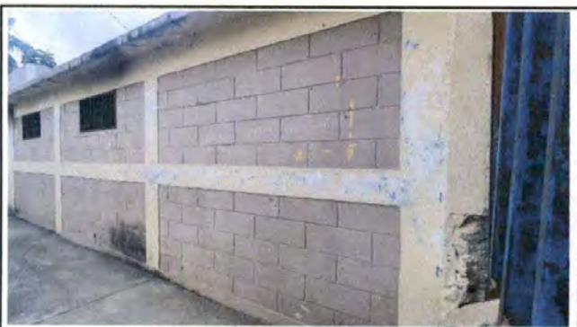
Foto 5: Muros con pintura en mal estado
